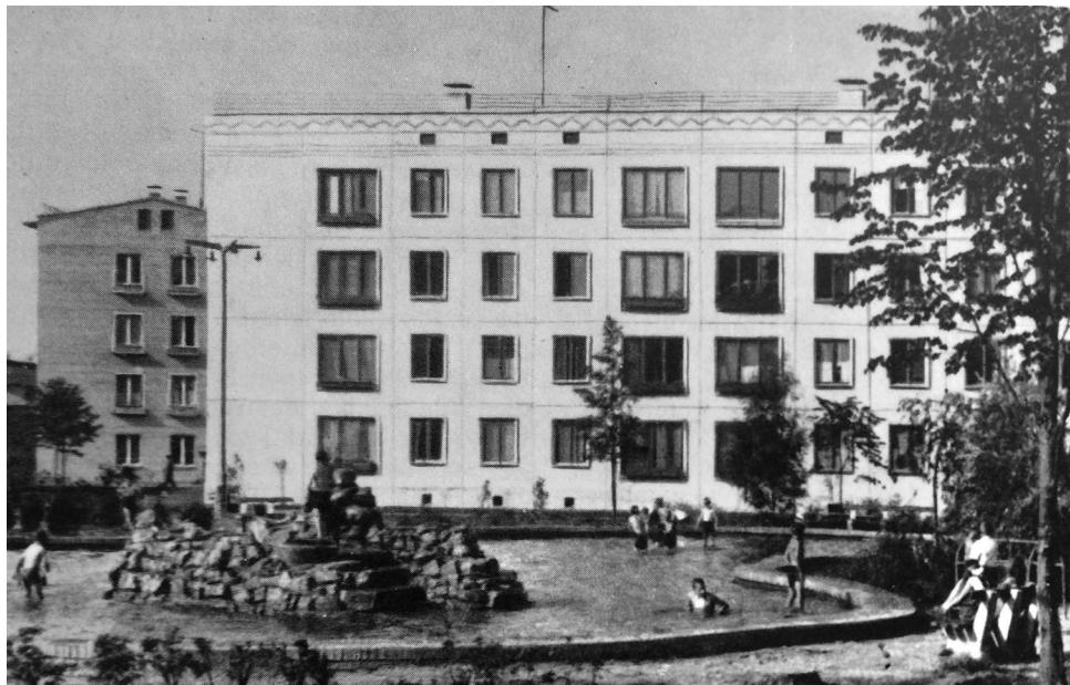
Abb. 11: Viergeschossiges Wohnhaus mit tragenden Stahlbeton-Zwischenwänden, Moskau, Nowye Tscherjomuschki (Franz Reuter: *Der neunte Wohnkomplex von Neu-Tscheremuschki im Südwestwohngebiet von Moskau*, in: *Deutsche Architektur* 11 [1958], S. 600)
